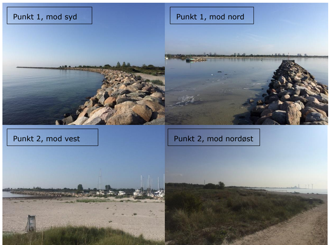
Figur 5-8 Forslag til ydre sikring ved Vallensbæk havn. punkterne 1 og 2 illustrere havnen, punkt 3 er vist på Figur 5-7.
