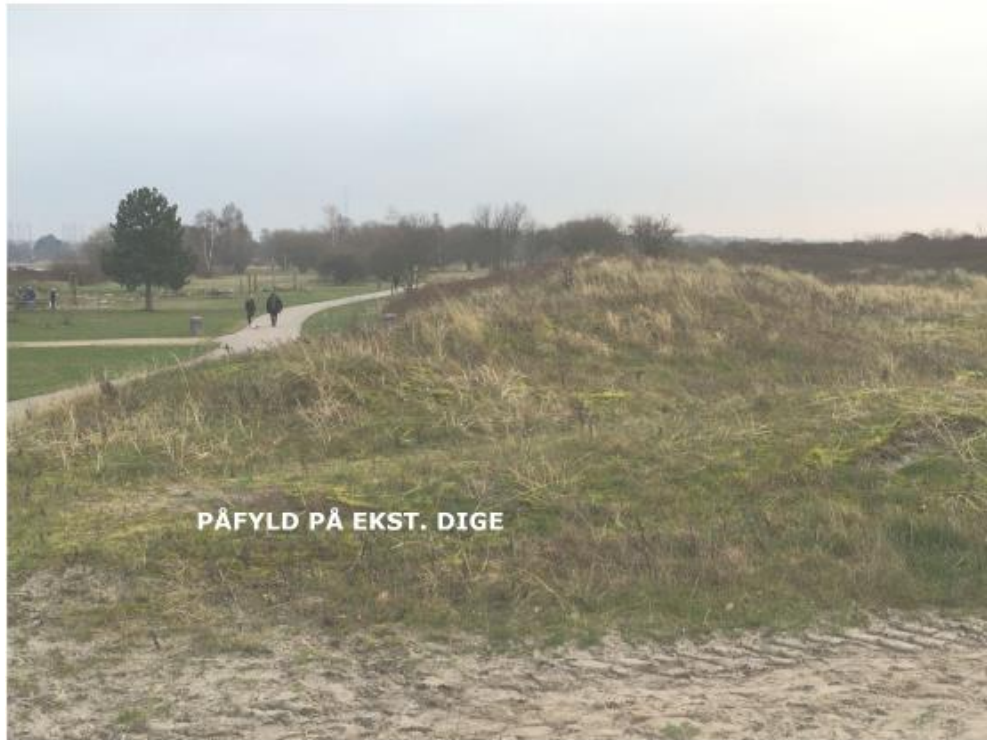
Figur 23 De eksisterende diger mellem strandparksøerne kan simpelt forhøjes ved at påfylde yderligere materiale og sikre, at bevoksningen følger med op.
