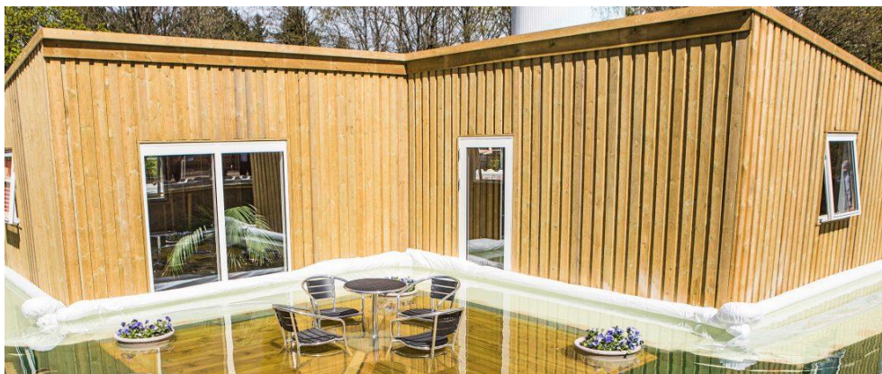
Figur 20 "FloodFrame" er et eksempel på en af de løsninger der er på markedet, egnet til beskyttelse af enkeltejendomme. www.floodframe.com
