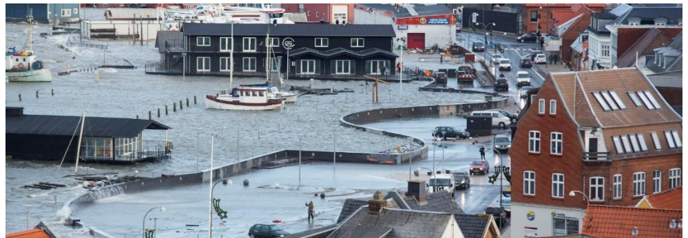
Figur 36 Eksempel på højvandsmur, Lemvig
