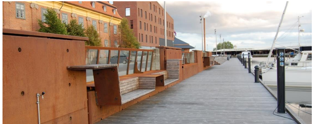
Figur 35 Eksempel på højvandsmur
